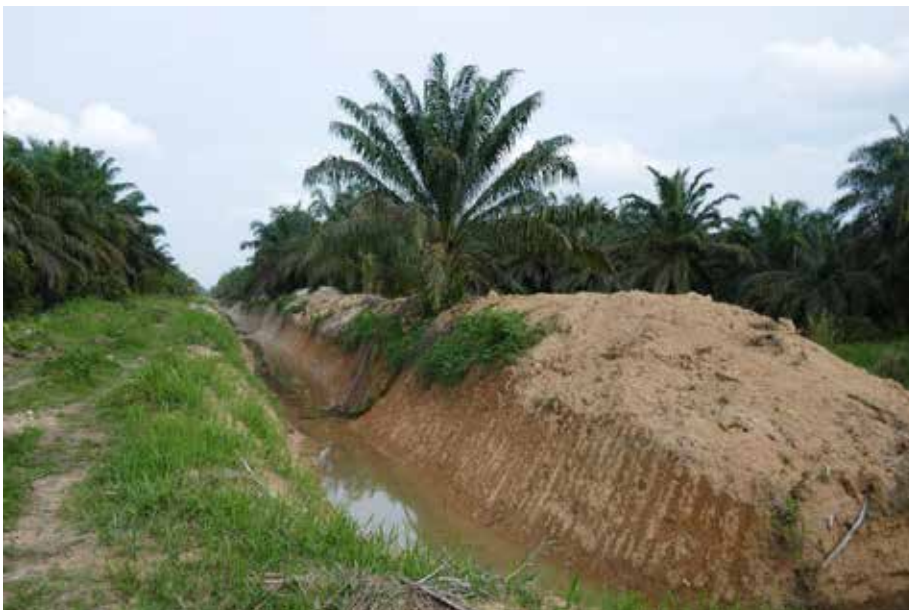
Auf einer industriellen Ölpalmenplantage befindet sich ein kürzlich errichteter Hochwasserschutzdamm.
